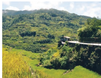
Ambuklao, Filipinas 105 MW; Rehabilitación completa y aumento de la potencia de la turbina en un 40 %
