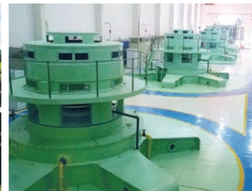
Temascal, México 4 x 38,5 MW; Rehabilitación de cuatro unidades de la central hidroeléctrica
