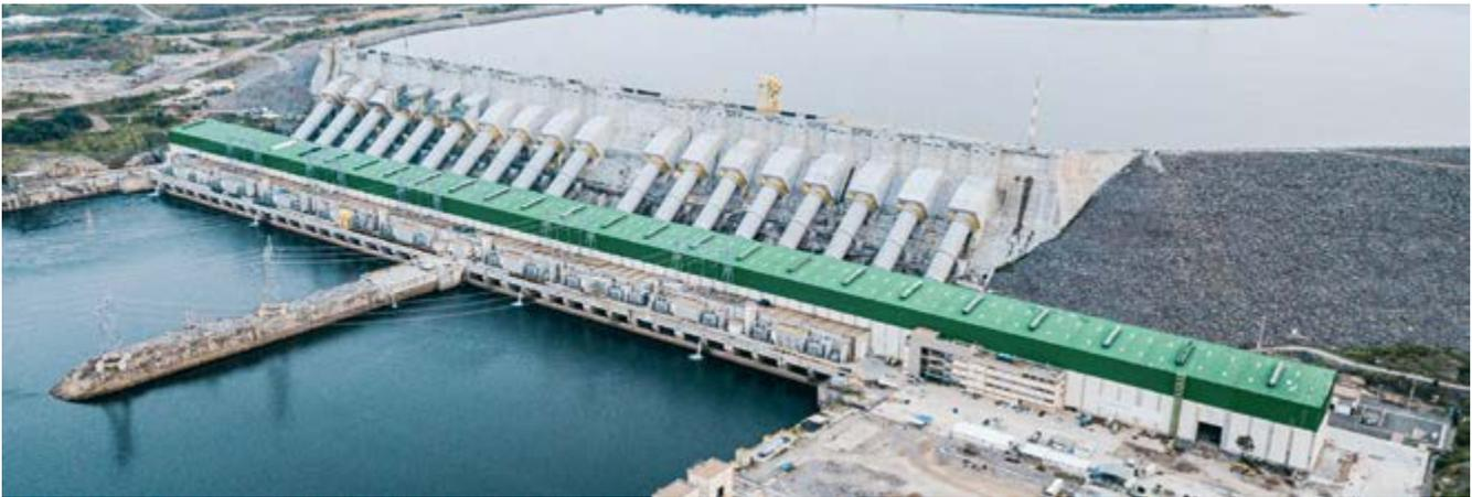
Das Hauptkrafthaus beherbergt 18 vertikale Francismaschinensätze mit einer Gesamtleistung von mehr als 11.000 MW. Damit ist Belo Monte das drittgrößte Wasserkraftwerk der Welt.
