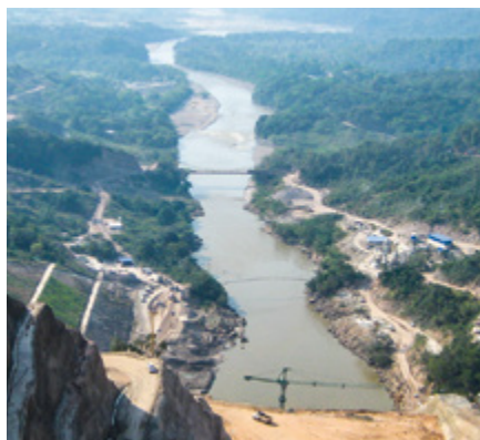
Blick auf die Baustelle und den Fluss
