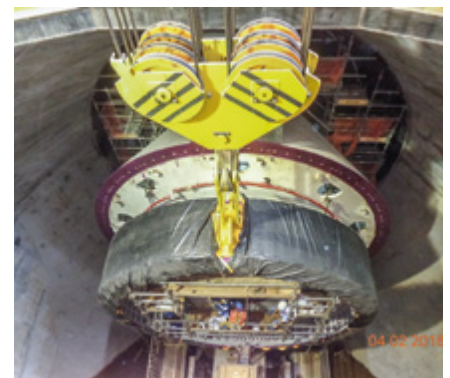
Installation des Rohrturbinengenerators
