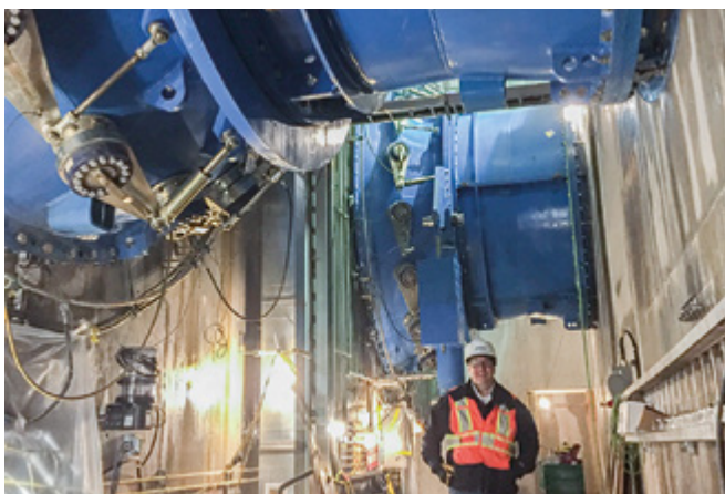
Installierte Rohrturbine
