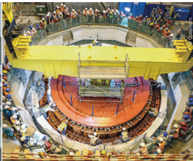
Einheben des Rotors Maschine #1
