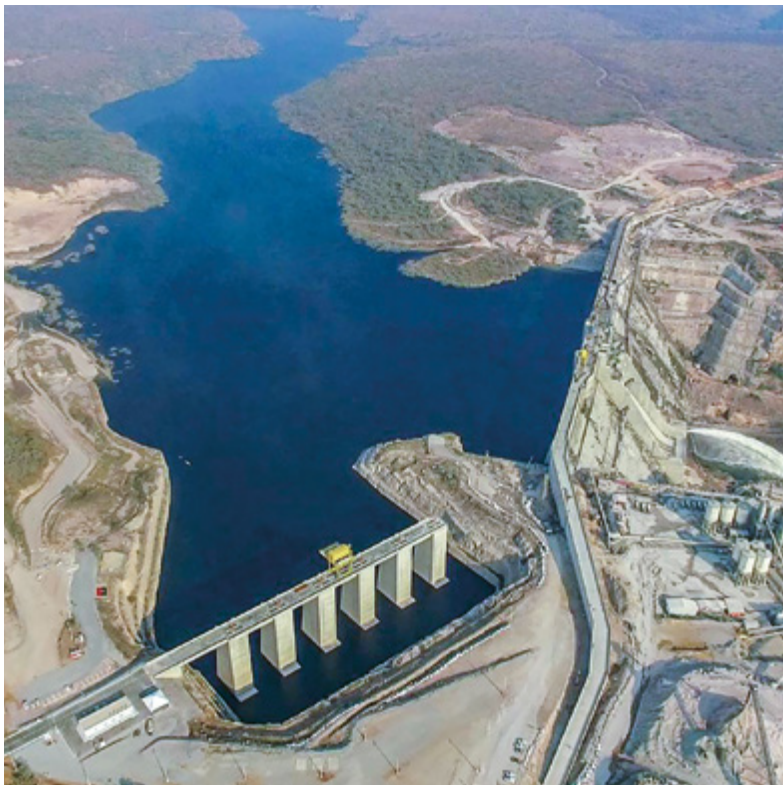
Blick auf Krafthaus, Damm und Umgebung
