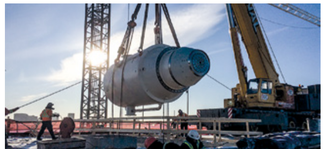
Installation der Rohrturbine
