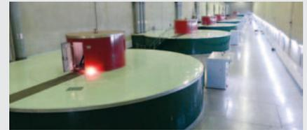
Derzeit werden die bestehenden rotierenden Erregermaschinen der Maschinensätze #1 bis #4 durch komplett statische Erregungssysteme ersetzt. An den Maschinensätzen #7 und #8 wird die bestehende statische Erregung durch eine neue ersetzt.
