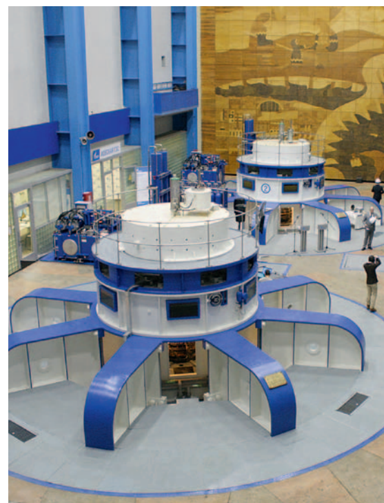
Гидроагрегаты № 1 и № 2 после модернизации
