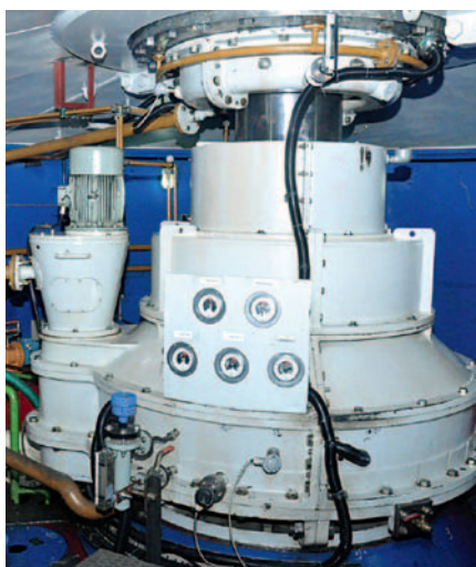
Шхта турбины после модернизации
