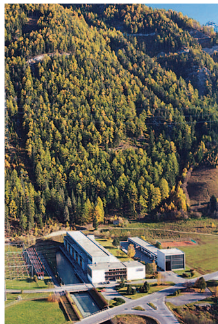
□ Здание ГЭС и распределительная подстанция
