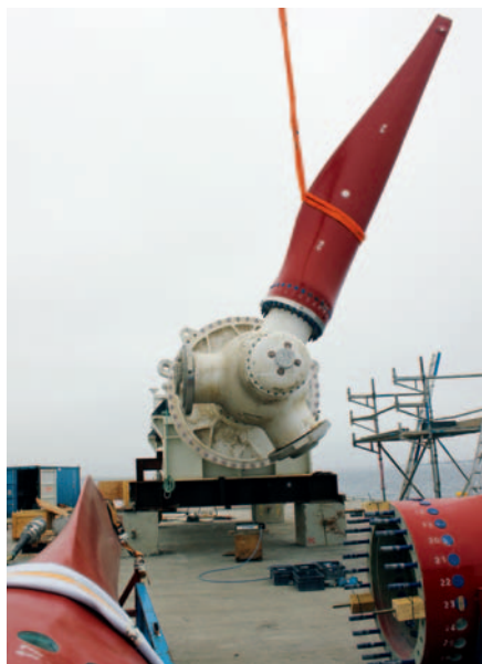
□ Монтаж HS1000 в исследовательском центре ЕМЕС (Шотландия)
