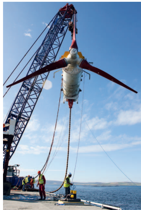
□ Монтаж HS1000 в исследовательском центре ЕМЕС
