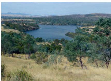
Река Деруэнт в районе ГЭС «Repulse»
